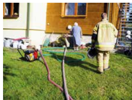
8.08.23-Czchów wypompowywanie wody z zalanej piwnicy
