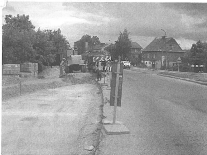
W Jurkowie powstaje nowe rondo. Zakończenie prac przewiduje się we wrześniu.
