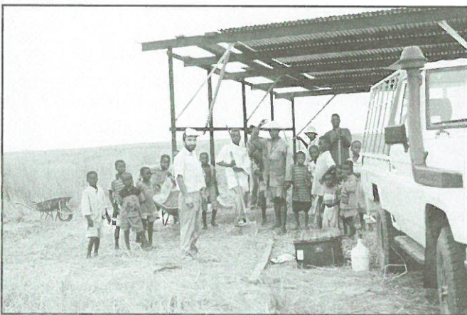
Przy budowie kaplicy
