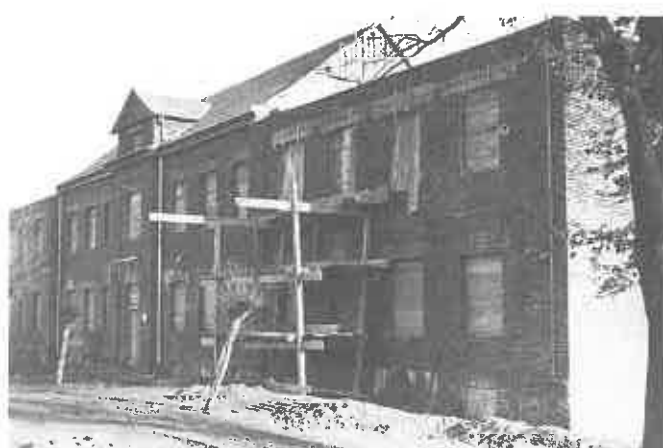
Nowa szkoła w budowie. 12 grudnia 1936.
