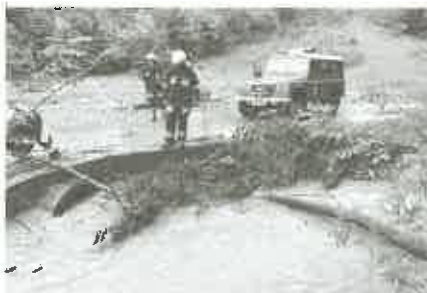
17.05.2014 r. Wytrzyszczka - udrażnianie zatkanego przepustu.
