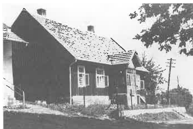
Stary budynek przedszkola
