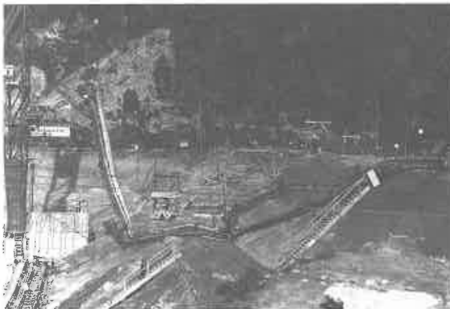
Rożnów. Podczas budowy zapory załamanie rusztowania.
