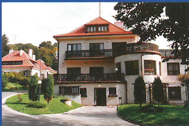
Ośrodek Szkoleniowo - Wypoczynkowy Elektrowni "Łaziska".
