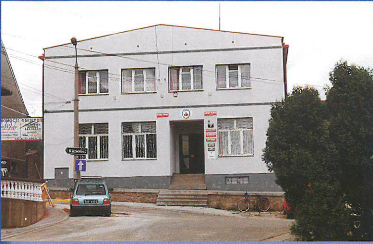
Budynek Urzędu Gminy.
