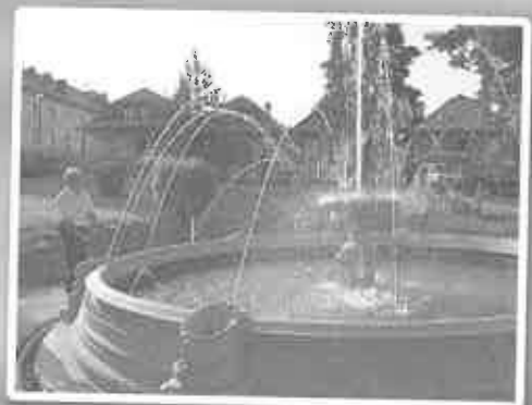
Nawa fontanny na remontowanym ryнку w Czchowie.
