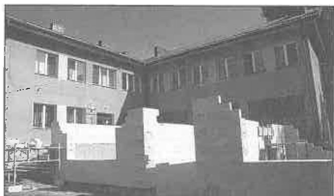
Złota - budowa sali gimnastycznej
